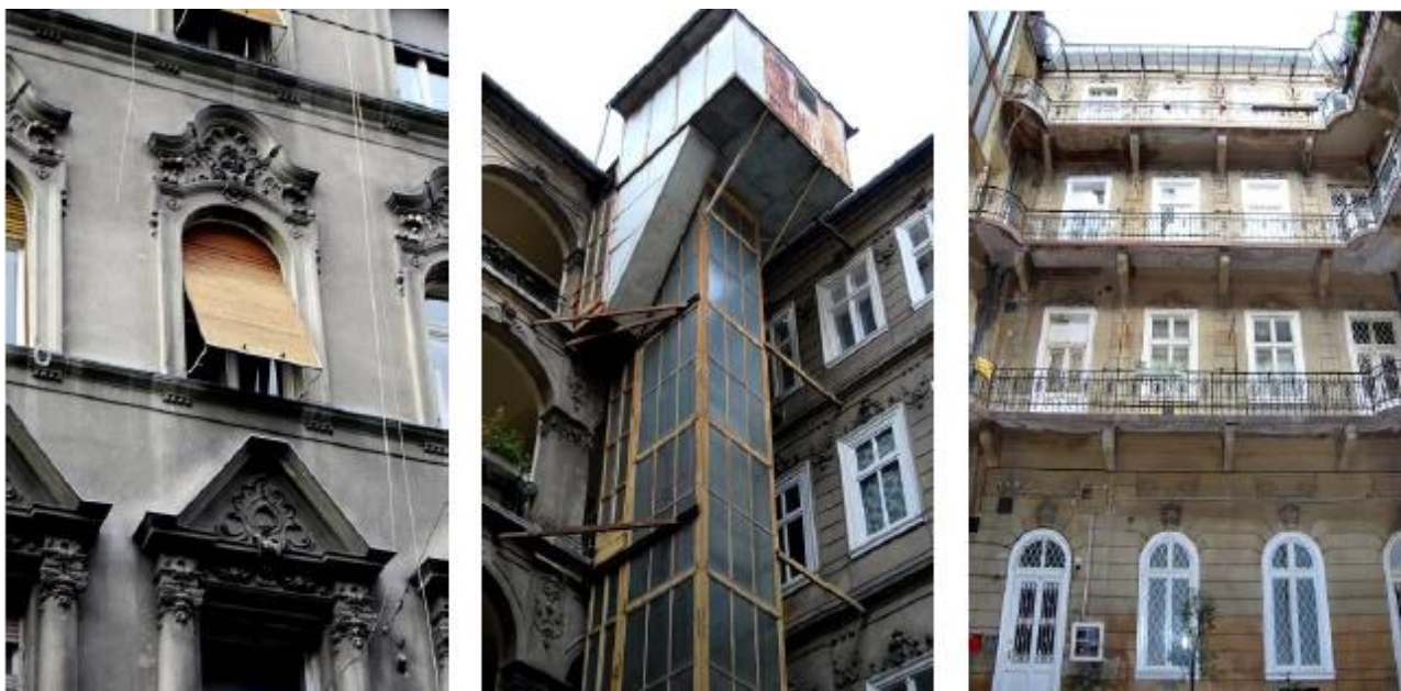
Utcai oldalon esslingeni faredőnyök vannak, az udvari nyílászárók külső tokborításúak és egységesek
