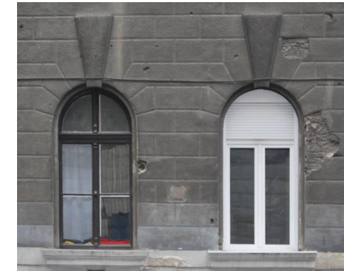
Kisebb bevilágítást adó, vastag keretezésű, az íves záródást nem követő, műanyag ablak
