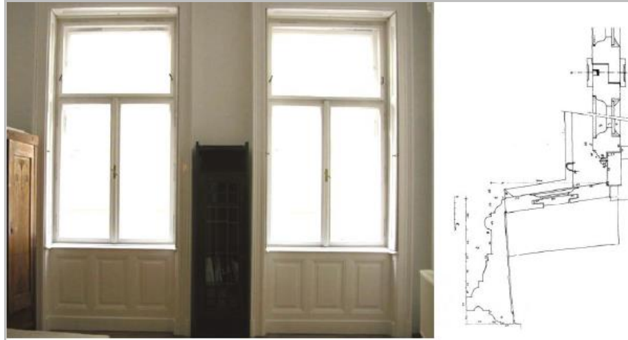
Vázta blázatos tok- és bélletborításos T osztásos ablakok belső oldali nézete;
